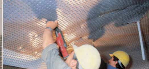
Nei tunnel DELTA®-PT serve come supporto per cls a spruzzo.
